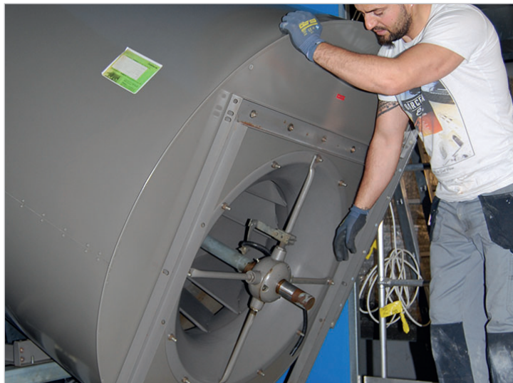
L'ancien ventilateur est démonté et ...
